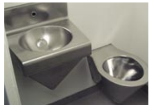
Tvättfat i rostfritt med sensorstyrd vattentillförsel. WC i rostfritt som styrs utifrån. Sluttande golv med öppning till "polisbrunn".
