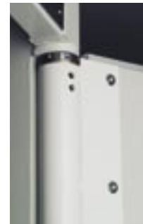
Säkerhetsgångjärn i WC-dörr så att inte häktad ska kunna skada sig själv.
