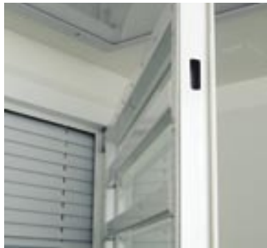
Säkerhetsfönster med glasalarm. Glas (härdat eller laminat) i valfri klassifisering.
