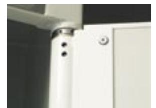
Säkerhetsgångjärn i WC-dörr.
