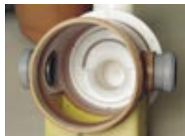
"Polisbrunnen" har en insats som kan lyftas ur för analys av undanhållande av t ex bevis.
