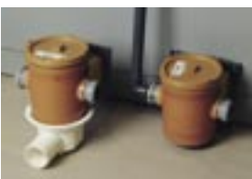
"Polisbrunnen" har en insats som kan lyftas ur för analys av undanhållande av t ex bevis.
