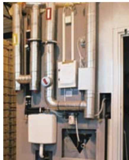
Nischvägg med bl a vatten, ventilation, spillåda och elcentral.
