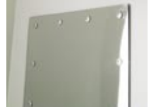
WC-belysning samt spegel i polycarbonat.
