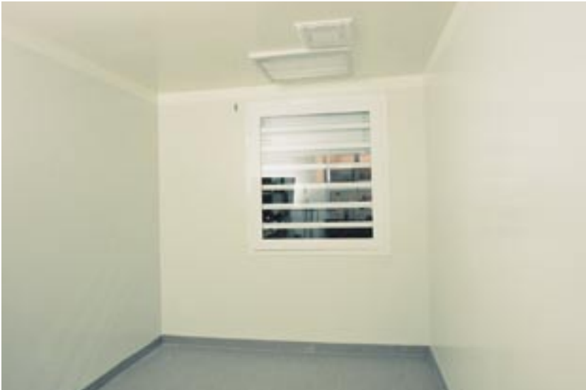
Förvaringsrummet för berusade/omhändertagna personer har sluttande golv som mynnar ut i en "polisbrunn".
