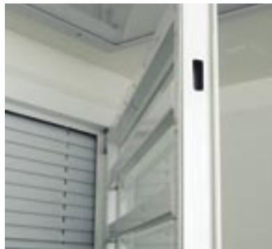
Säkerhetsfönster med glasalarm. Glas (härdat eller laminat) i valfri klassifisering.
