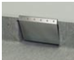
"Polisbrunnen" har en insats som kan lyftas ur för analys av undanhållande av t ex bevis.
