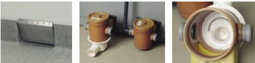
"Polisbrunnen" har en insats som kan lyftas ur för analys av undanhållande av t ex bevis.
